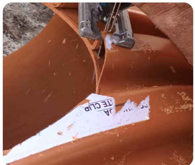
Secuencia de instalación de un clip elastomérico
