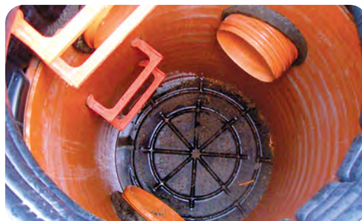
Acabado del fondo de la cámara de inspección con base estanca (necesario con freático)
