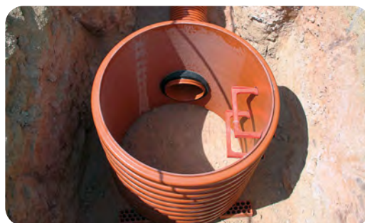
Acabado del fondo de la cámara de inspección rematado con hormigón (solamente recomendable sin freático)
