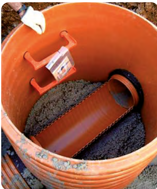
Acabado interior de un pozo a 180°
