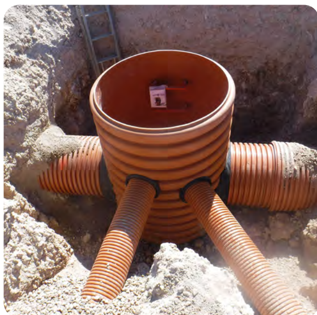
Ejecución de acometidas realizadas in situ
