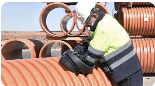
Secuencia de instalación de un clip elastomérico
