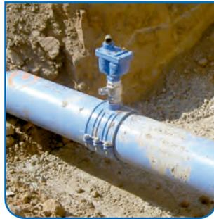
El collarín debe de quedar perfectamente solidario al caño. No se deben utilizar collarines multi-diámetros, sino collarines para caños PVC con diámetros específicos para cada DN.
