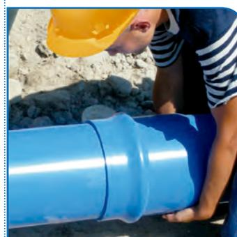
Dar un empujón firme y seco con el caño cuyo cabo se va a introducir en la copa para, de esta forma, aprovechar la inercia del caño. Introducir el cabo hasta que se oculte la marca.
