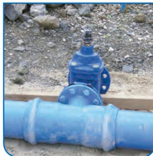
Con el fin de garantizar la resistencia estructural de la red, es imprescindible y fundamental el anclaje del accesorio al terreno.
