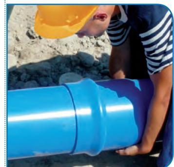
Dar un empujón firme y seco con el caño cuyo cabo se va a introducir en la copa para, de esta forma, aprovechar la inercia del caño. Introducir el cabo hasta que se oculte la marca.
