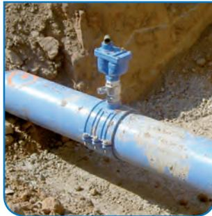
El collarín debe de quedar perfectamente solidario al caño. No se deben utilizar collarines multidímetros, sino collarines para caños PVC con diámetros específicos para cada DN.
